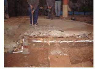
084 Treballs d'ampliació d...
