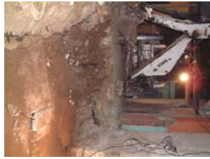
034 Treballs d'ampliació d...
