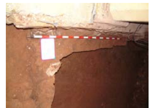
112 Estructura UE 312.JPG
