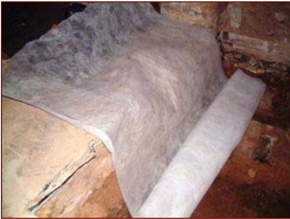
Cobrició amb geotèxtil de la riostra identificada amb l'UE 105
