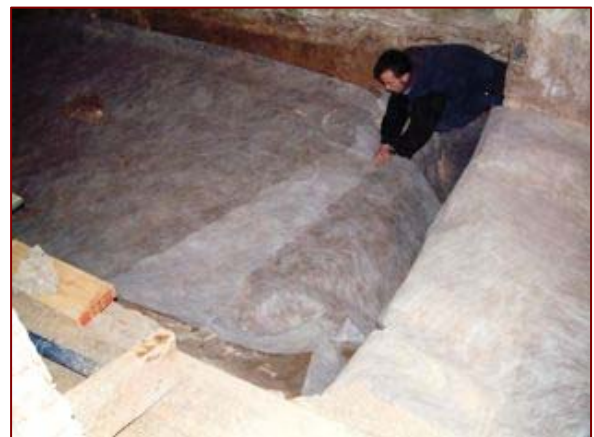
Procés de col·locació del geotèxtil a la cala 1
