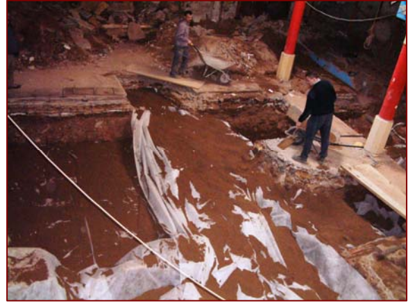
Vista del procés de rebliment a la zona central de la cala 3
