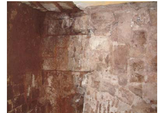
008 Detall de la mitgera occidental en la zona de la cala 2.JPG
