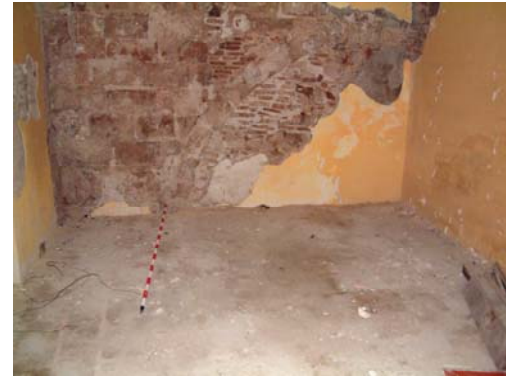
002 Ubicació Cala 2 amb el paviment UE 201 .JPG
