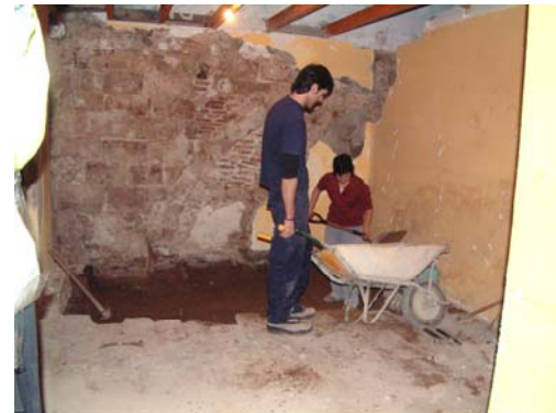
006 Treballs d'excavació en la cala 2.JPG
