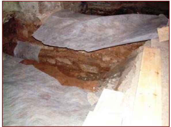
Cobrició amb geotèxtil de la riostra identificada amb l'UE 105
