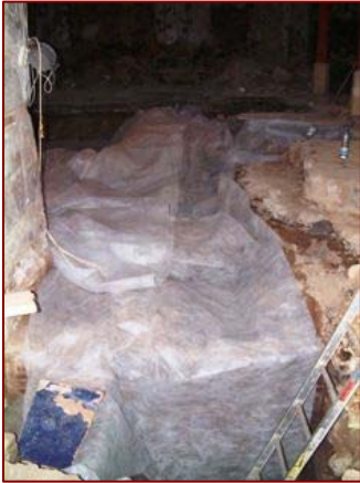
Col·locació del geotèxtil al sector nord de la cala 3
