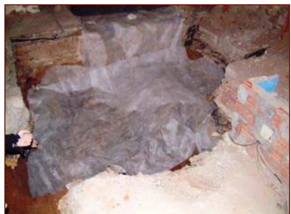
Procés de col·locació del geotèxtil a la cala 1
