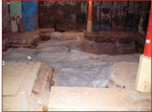
Vista est-oest de la cala 3, durant la col·locació del geotèxtil
