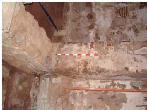
029 Vista general de la riostra UE 105 i el pilar construït .JPG
