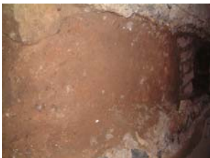
025 Vista general de la cal...
