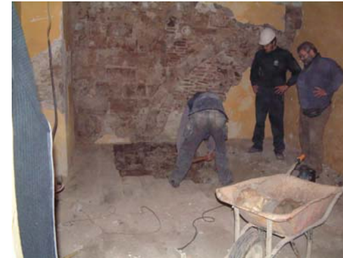
003 Treballs d'obertura de la cala 2 amb l'eliminació del pa.JPG
