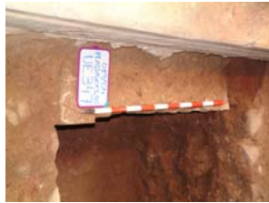
150 Detall del mur UE 347 ...
