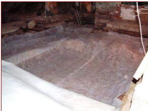
Imatge general de part de la zona sud en el moment de la col·locació del geotèxtil en el paviment de lloses UE 325, i els murs UE 335, 331, 343
