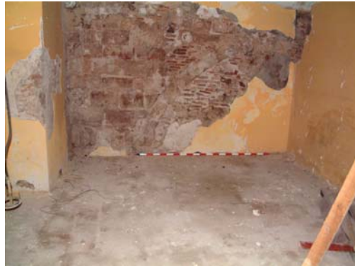
001 Cala 2 abans d'iniciar els treballs .JPG
