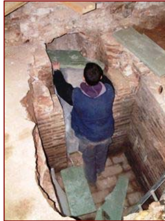
Vista del procés de cobriment de l'estructura UE 332 identificada en la zona nord
