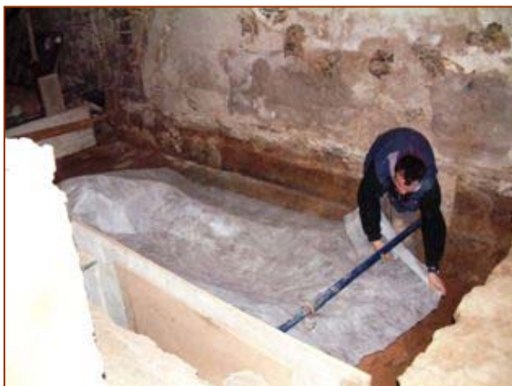
Procés de col·locació del geotèxtil a la cala 1
