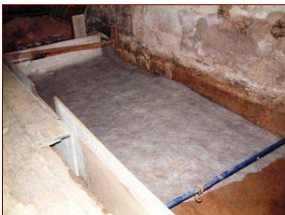
Procés de col·locació del geotèxtil a la cala 1
