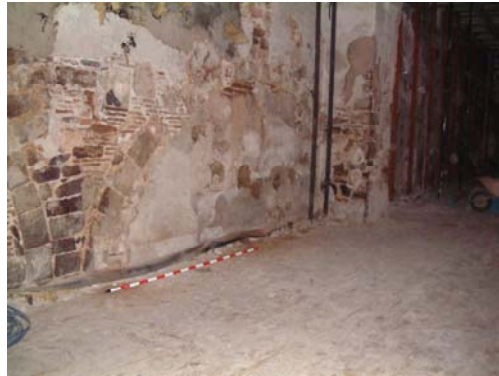
001 Ubicació Cala 1 abans d'inciar els treballs d'eliminació.JPG
