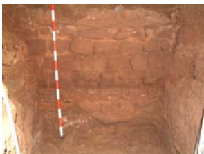
125 Detall del mur UE 309....
