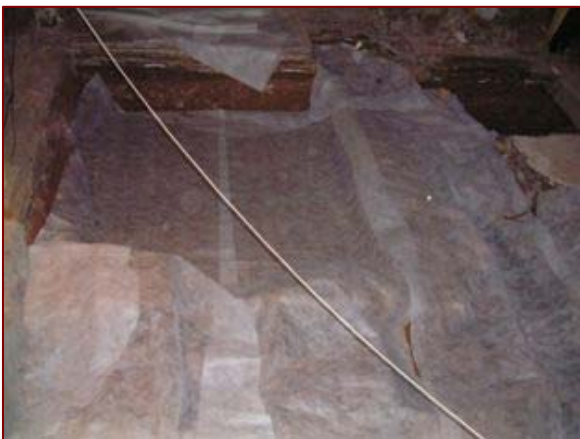
Diferents imatges del procés de col·locació del geotèxtil a la cala 3
