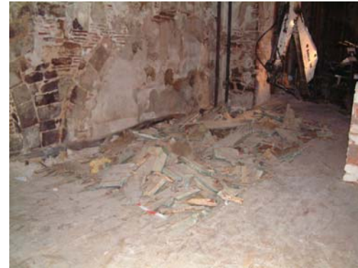
002 Treballs d'obertura de la Cala 1.JPG
