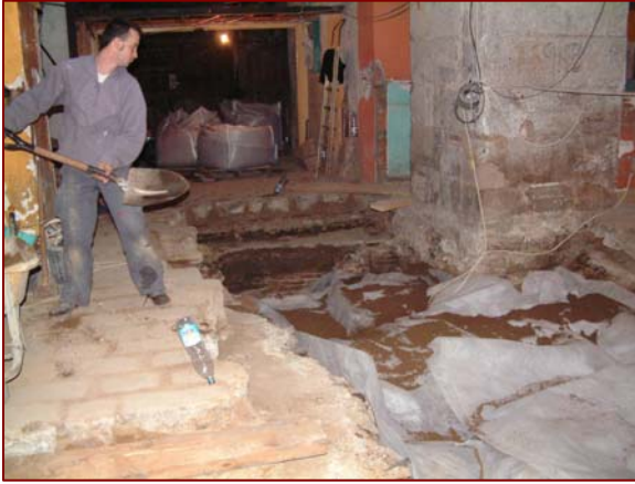
Vista del procés de rebliment a la zona central de la cala 3
