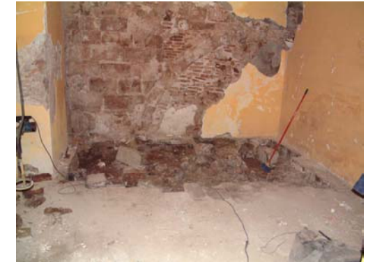
004 Vista general de la cala 2 després de l'eliminació del p.JPG
