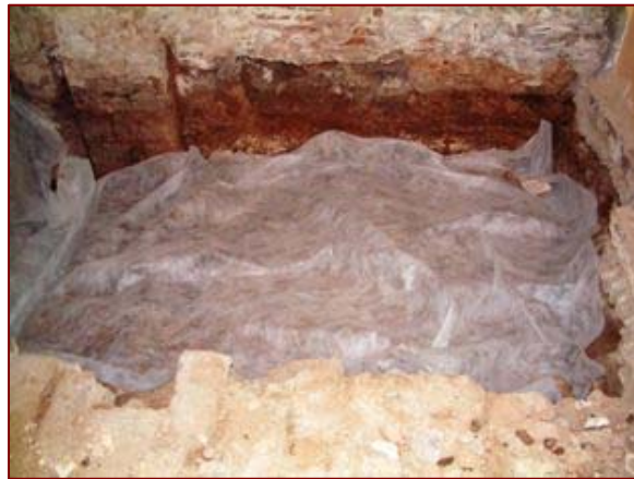
Procés de col·locació del geotèxtil a la cala 2
